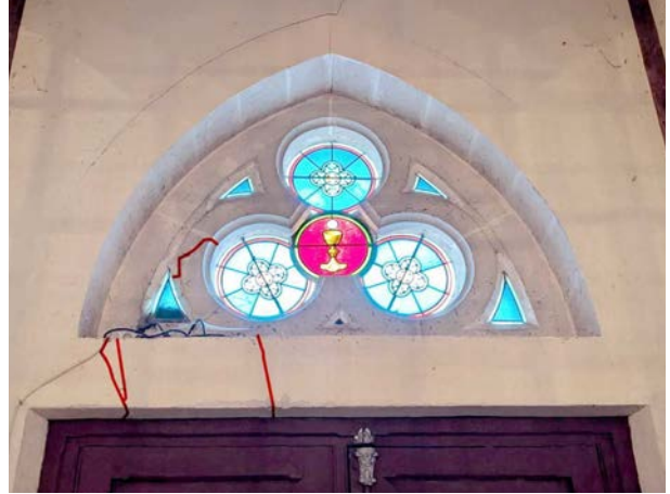
7 & 8 - Fissures traversantes sur le remplage de la verrière en trilobe et fissure dans les joints du linteau de la porte d'entrée
