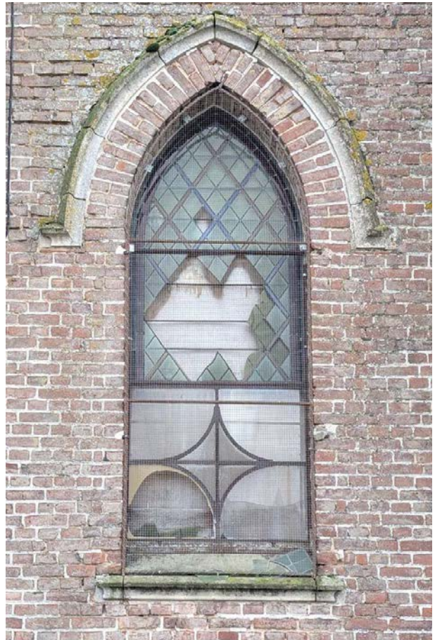
40 & 41 - Verrières de la façade occidentale, en très mauvais état - des panneaux complets sont à rétablir
