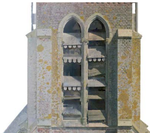
20 - Ruines des abats-sons en élévation Ouest du clocher Extrait des orthophototypes numériques de Drones BTP
