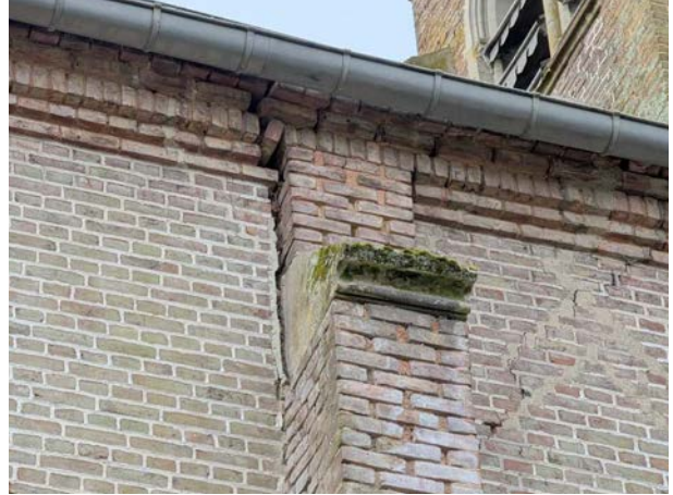
12 - Béance verticale entre le contrefort et la troisième travée de l'élévation Nord de la nef
