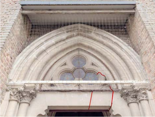
7 & 8 - Fissures traversantes sur le remplage de la verrière en trilobe et fissure dans les joints du linteau de la porte d'entrée
