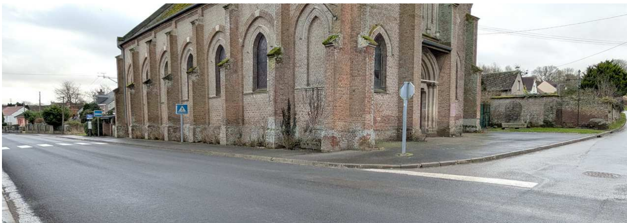
33 - Vue d'ensemble des abords présentant un aspect utilitaire, à l'angle de la Rue de Cléry et la Rue de la Croix
