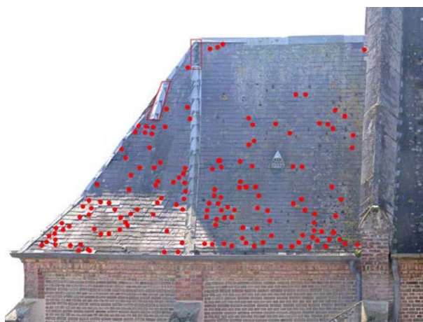
23 & 24 - Couvertures du chœur : sont entourés les éléments de faîtage et d'arêtiers lacunaires ; les points désignent les lacunes et mouvements d'ardoises (recensement non exhaustif) Extrait des orthophototypes numériques de Drones BTP
