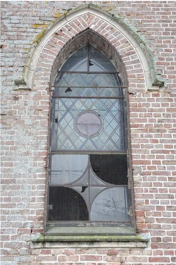
40 & 41 - Verrières de la façade occidentale, en très mauvais état - des panneaux complets sont à rétablir
